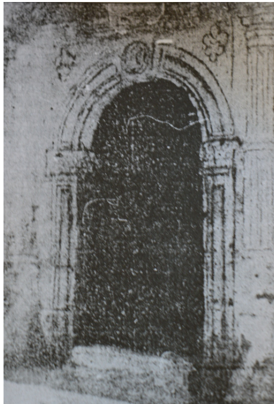
ΕΙΚ. 8 Το θύρωμα της εκκλησίας του Αγίου Αθανασίου που κατεδαφίστηκε, εμφανώς διαφορετικό από αυτό του Αγίου Νικολάου
