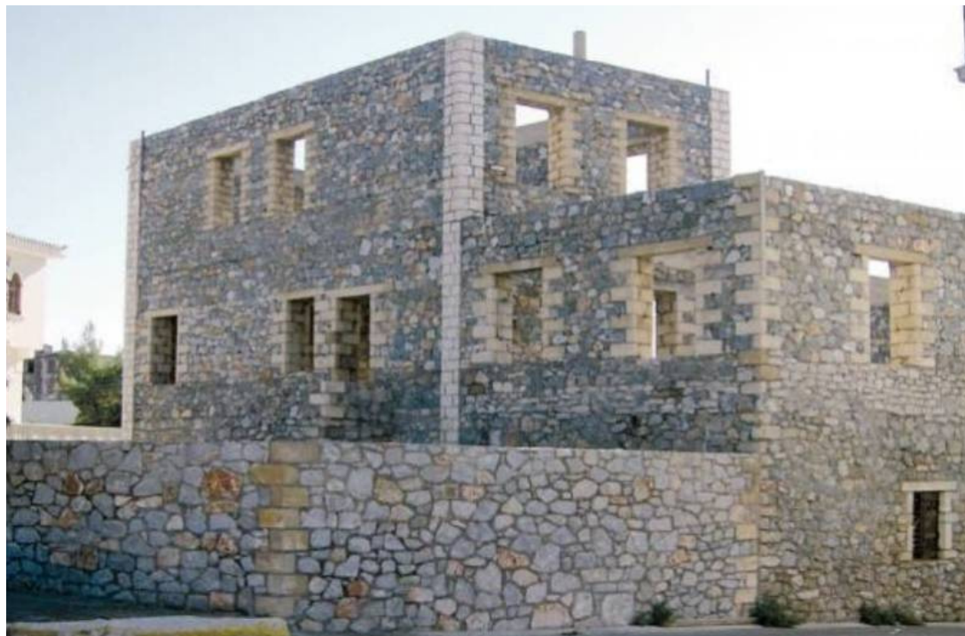
ΕΙΚ. 7 Το «Κορφιωτάκειο» υπό ανακατασκευή
